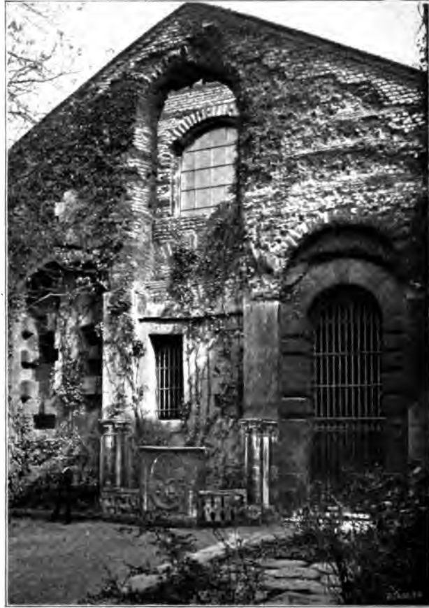
Ruines du palais des Thermes.
